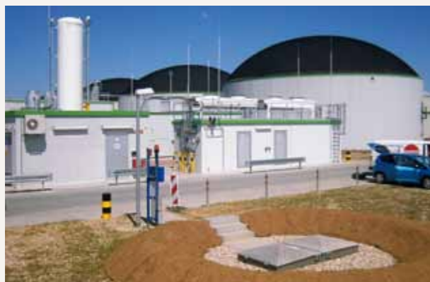
Unité d'injection de biogaz de la MITNETZ GAS à Leuben/Oschatz
