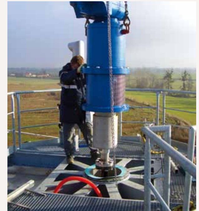
Montage de l'agitateur central d'un fermenteur vertical
