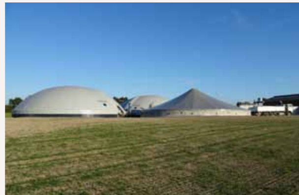
Unité de biométhanisation à Treize-Vents (France)
